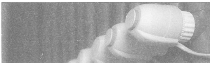
Fig. 4.5.68. Ventil de reglaj electric
