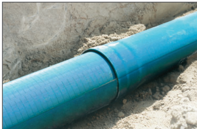
Fig. 9-32 Țevile de drenaj se montează pe terenul de joc
