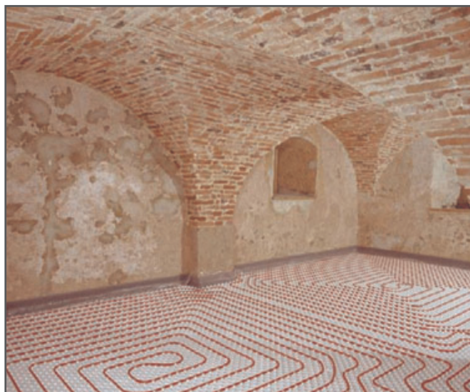
Fig. 3-22 Sistemul REHAU Placă cu nuturi vario
