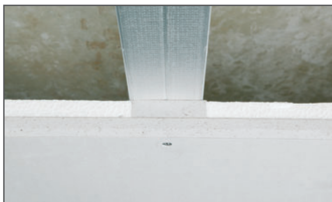
Fig. 4-6 Elemente de prindere în tavan montate
