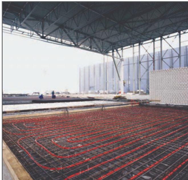
Fig. 9-1 Încălzirea prin pardoseală la un spațiu industrial
