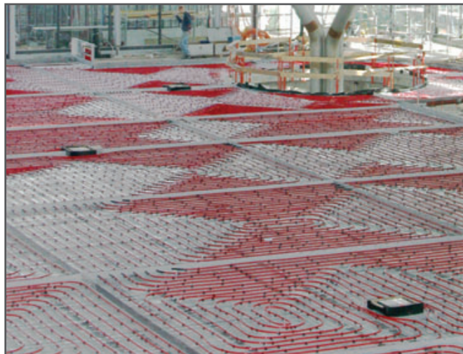
Fig. 3-43 Sistemul REHAU cu plasă de sârmă
