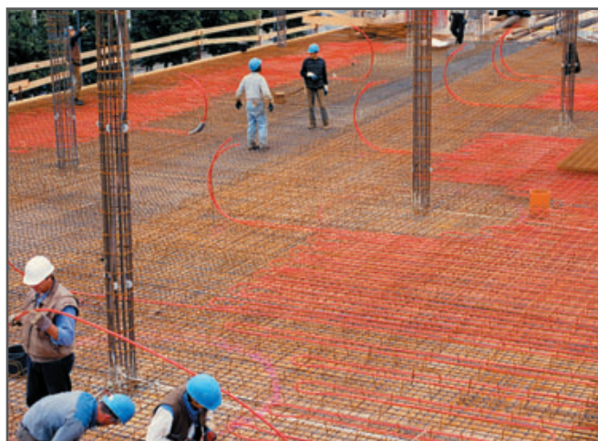
Fig. 8-5 Modul REHAU BKT montat la fața locului (pe șantier)
