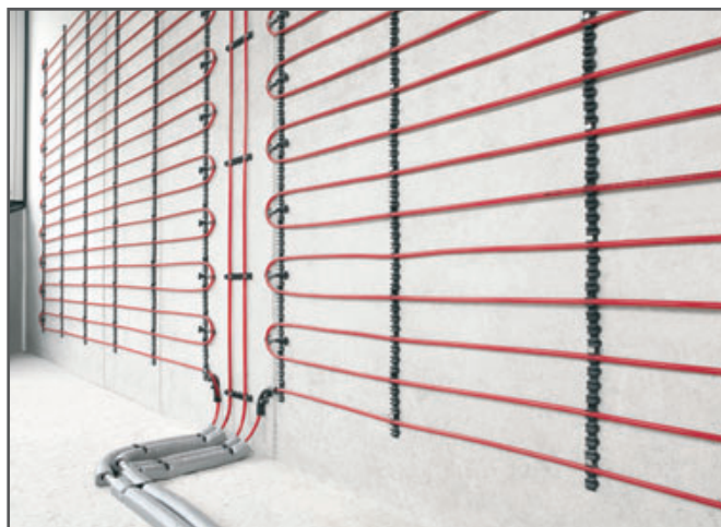
Fig. 4-15 Încălzirea/răcirea REHAU prin perete – sistemul umed de montare
