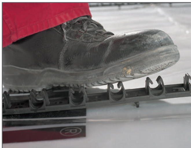
Fig. 3-39 Șinele REHAU-RAUFIX se vor apăsa în podea.
