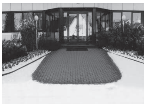
Figura 55 Încălzirea prin pardoseală în spațiile deschise
