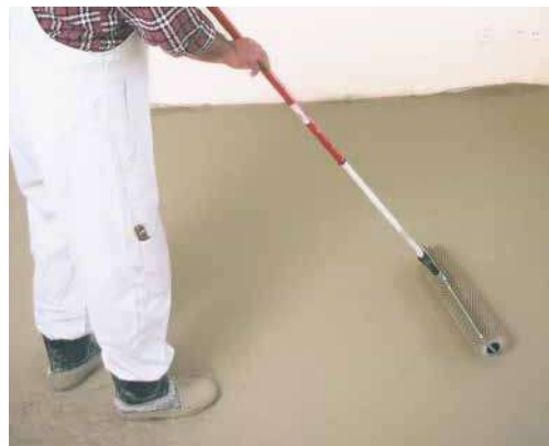
Dezaerarea sapei cu ajutorul trafaletului cu țepi
