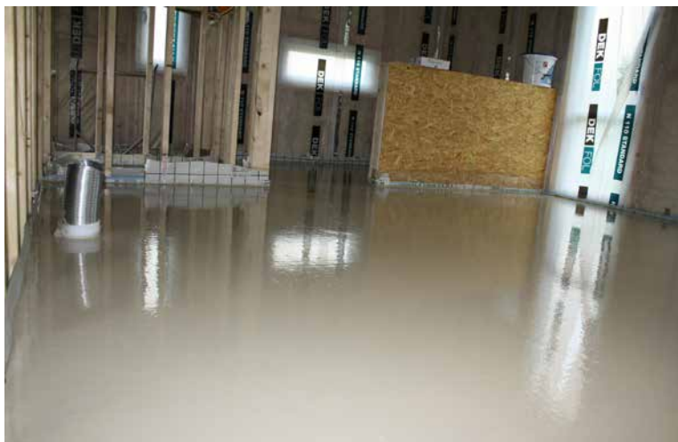
Etanșarea ferestrelor pentru 24 de ore - protecția șapei
