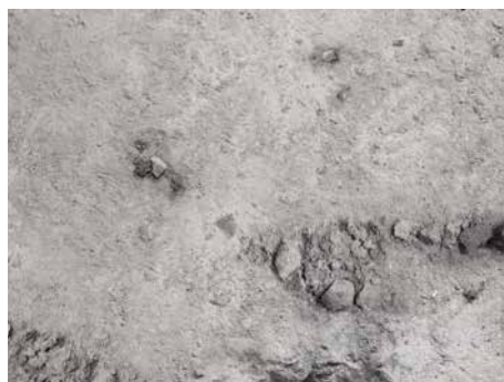
Toate suprafețele neaderente trebuie eliminate.
